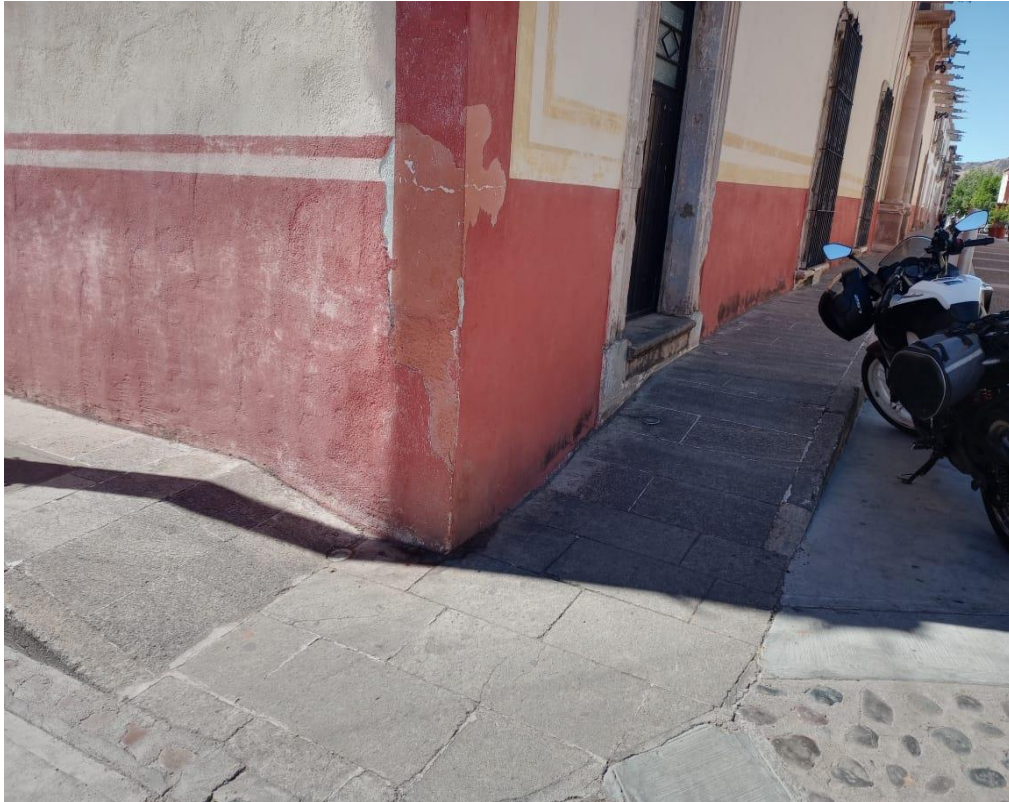
Rampa por fuera del edificio
